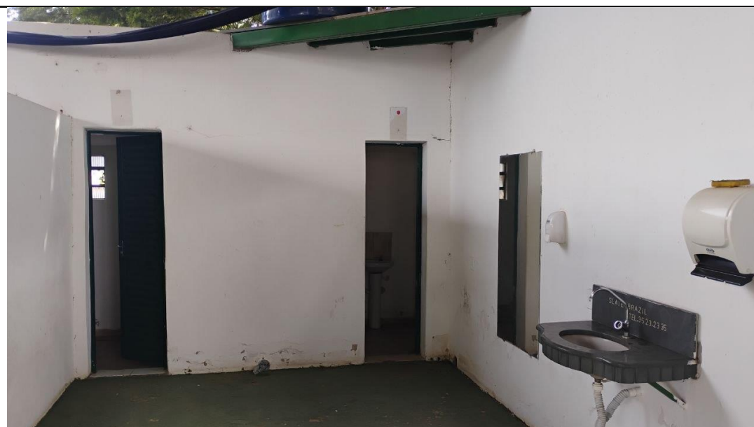
Fechamento de portas com alvenaria
