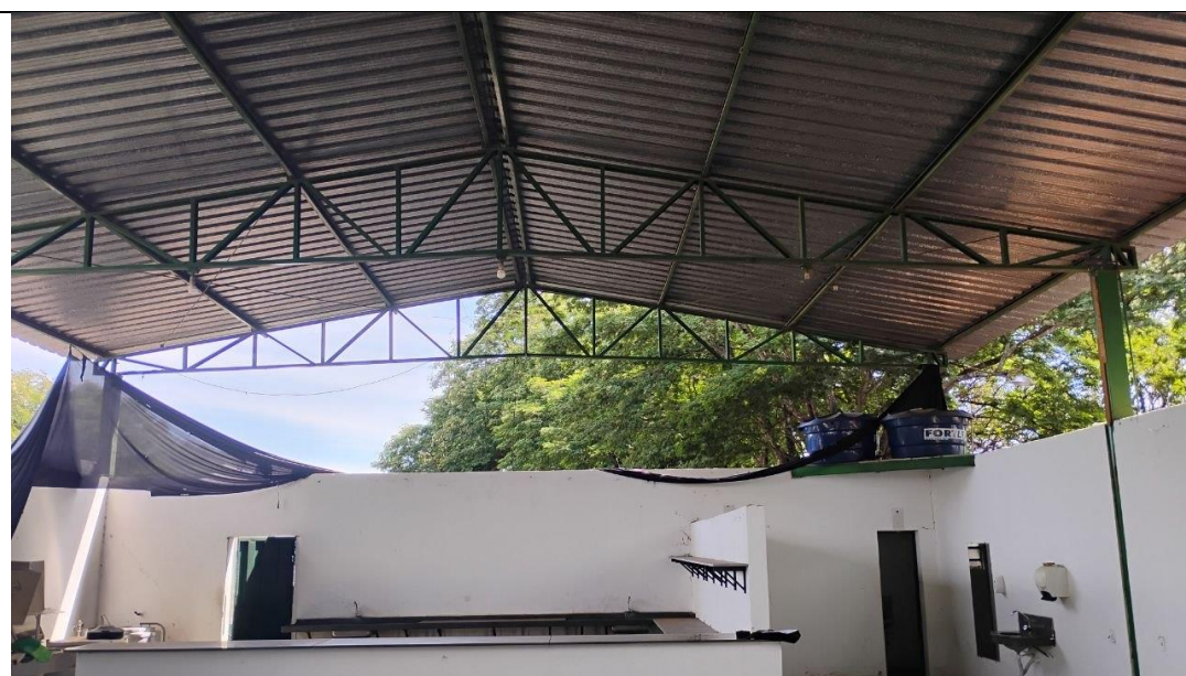
Fechamento superior no fundo com alvenaria rebocada e pintada
