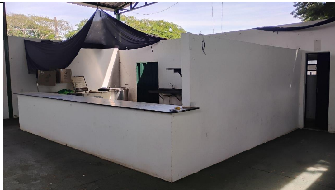
Alvenarias a demolir
