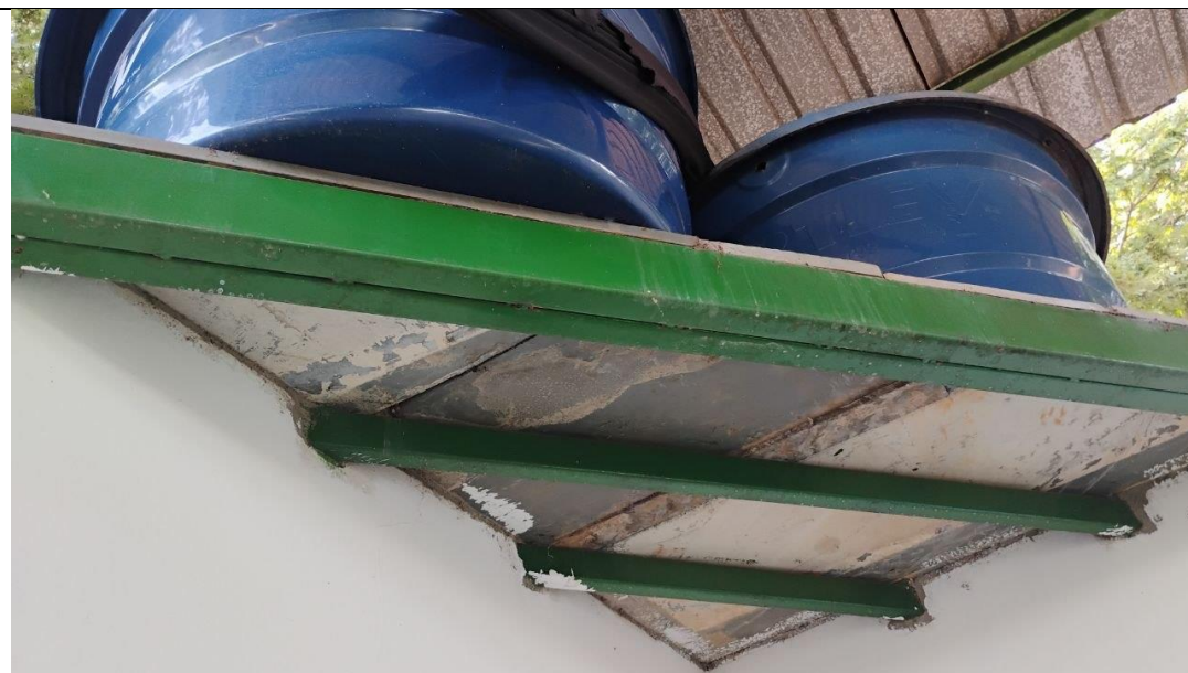
Remoção das caixa d'agua com reaproveitamento
