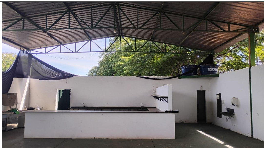
Local aonde será implantado os banheiros
